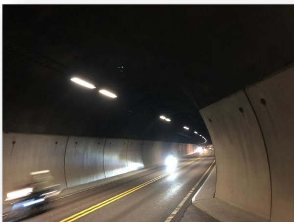
Foto: Varingen (Hagantunnelen)
